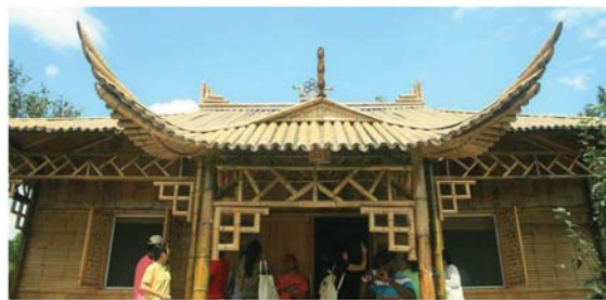
图3 2012年安吉县建造的竹建筑
